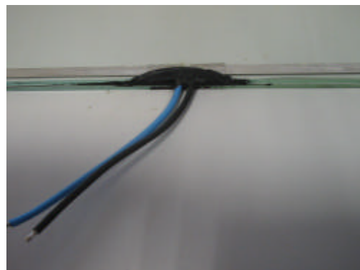
Kabelanschluß mit Glasausschnitt / Kabel im 180° Winkel zum Glas Glasausschnitt Versiegelt
